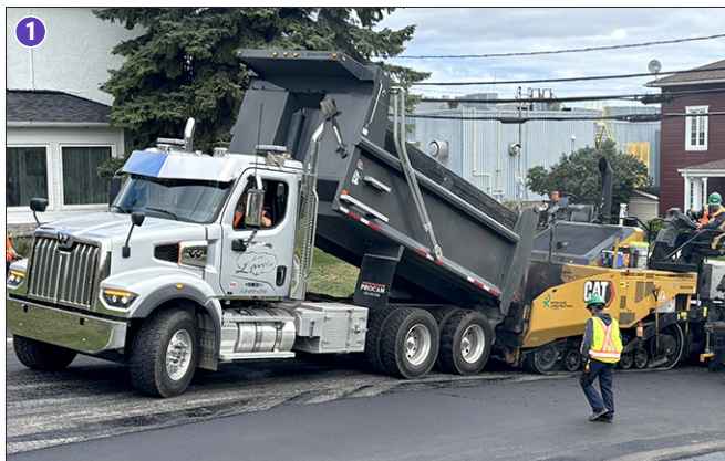
Zone Dubuc-Sud – ① Luc Lavoie effectuant des travaux de pavage sur la 7 e Avenue pour la Ville de Saguenay. ② Aménagement du Fjord prenant part aux travaux de planage de 1 re Avenue pour Ville de Saguenay.
