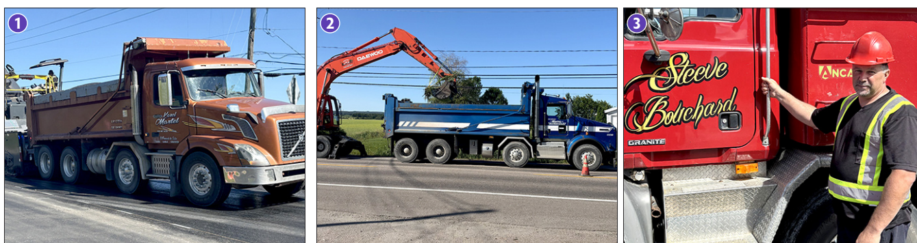
Zone Roberval – ❶ Karol Martel lors de l'asphaltage de la route 169 à Saint-Félicien. ❷ Maxime Tremblay effectuant des travaux en régie pour le Ministère à Saint-Prime. ❸ Steve Bouchard en attente d'un chargement.
