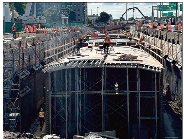
**Zone Sainte-Foy** – Construction d'un tunnel réservé au transport en commun sous le boulevard Laurier.
