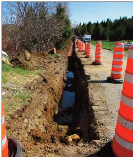
La méthode de construction de la ligne Hertel-New-York consiste à creuser une tranchée d'environ 1 m de largeur et de 1,5 m de profondeur, puis à y installer une canalisation bétonnée pour enfouir les deux câbles électriques de la ligne.
