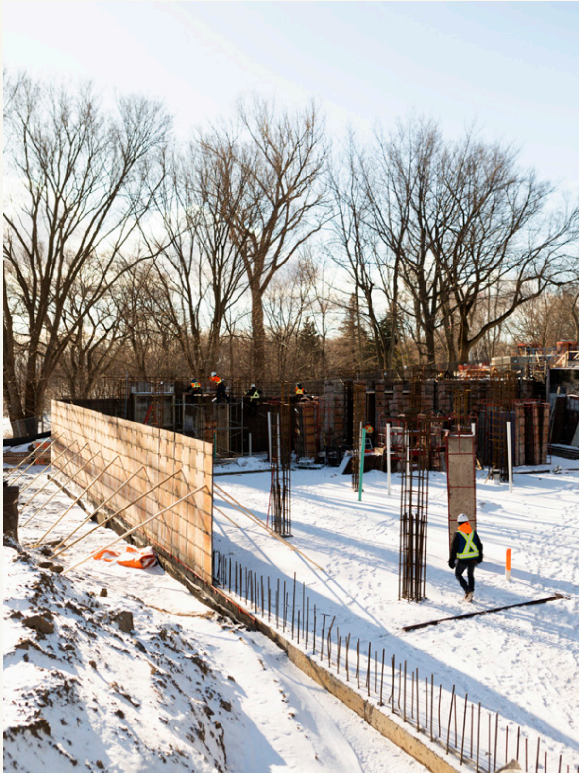
Délimitation du futur bâtiment.
